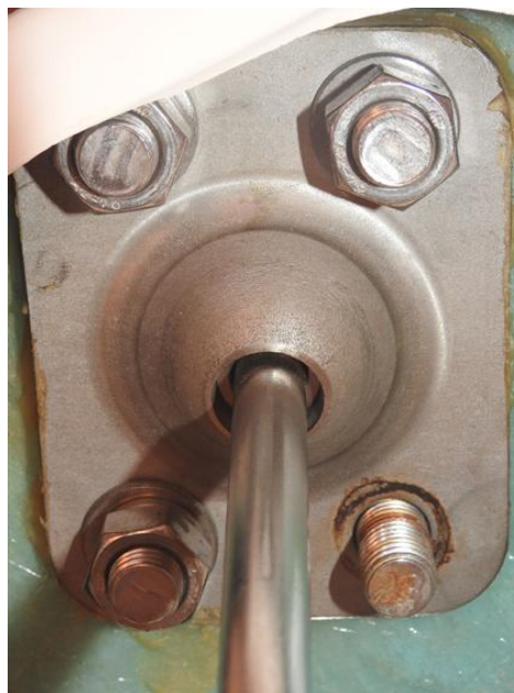
Die Ursache dieser Roststelle an der Pütting-Befestigung unter Deck ist Kondenswasser und muss beseitigt werden
