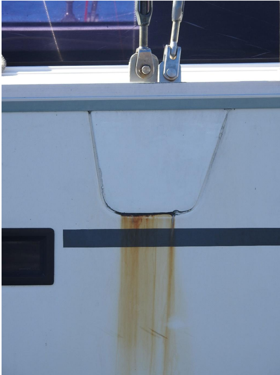
Rost fließt an der Rumpf-Pütting-Verbindung
